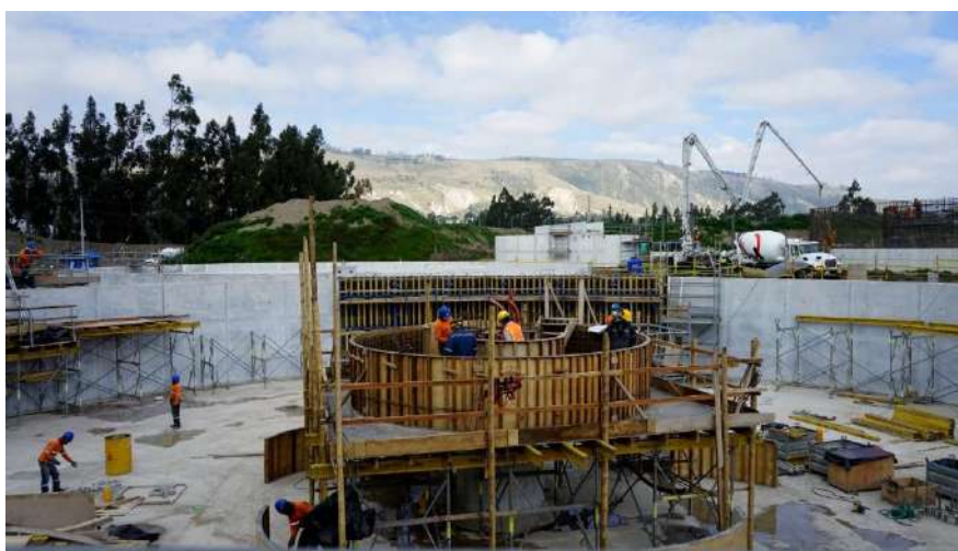
Imagen 20: Construcción PTAR - Plan Maestro de Alcantarillado
