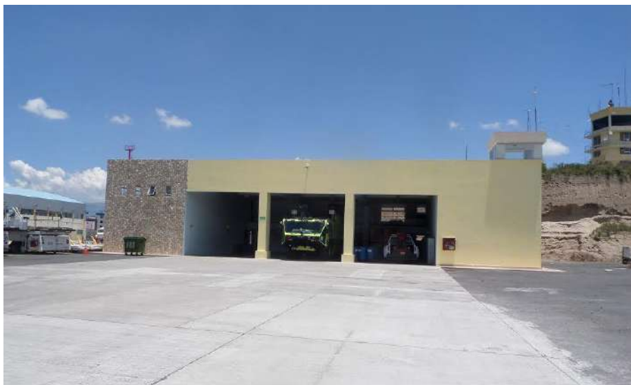
Imagen 18: Hangar de Bomberos Aeropuerto Internacional "Cotopaxi"
